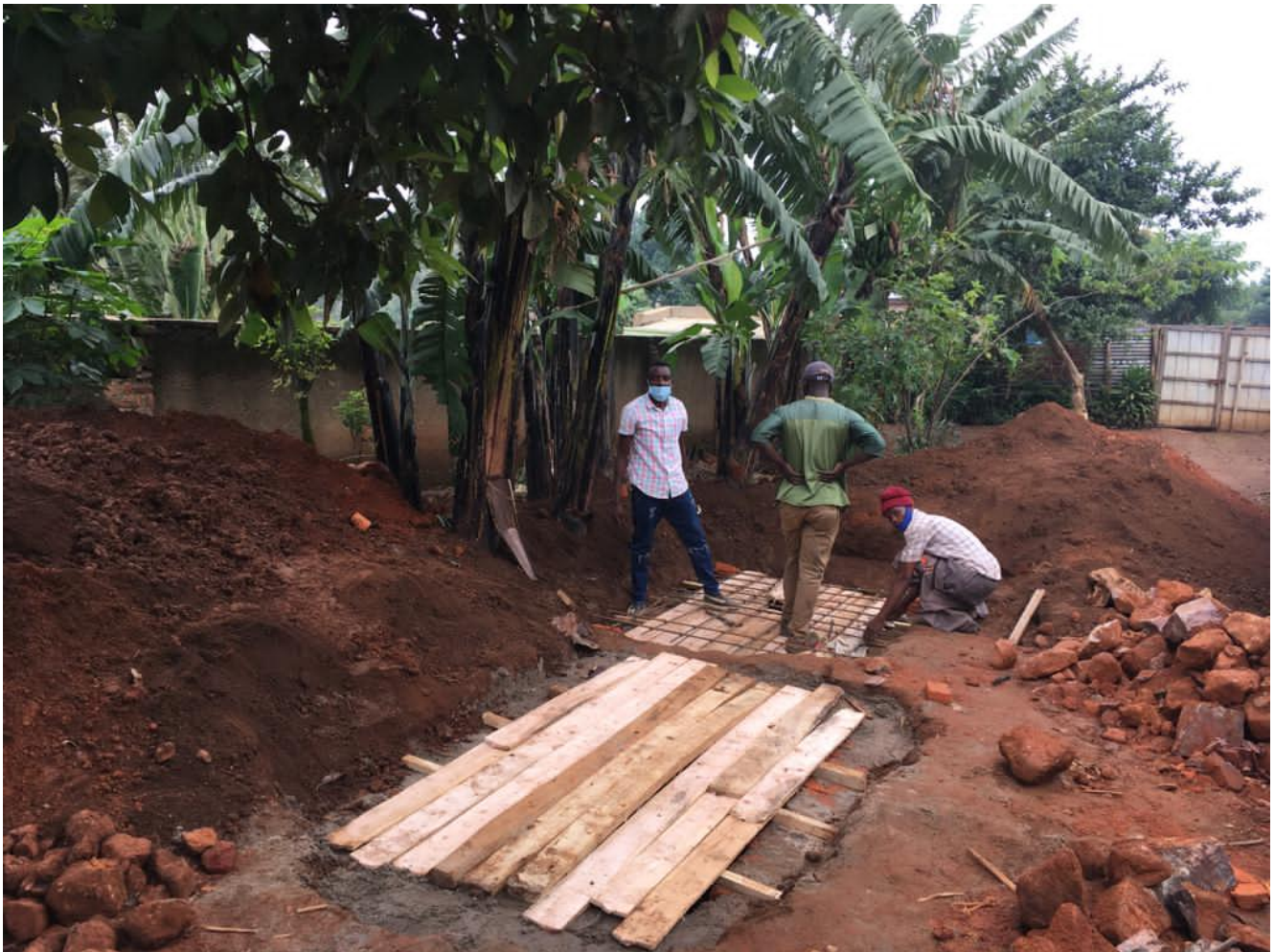
Les puits perdus terminés
