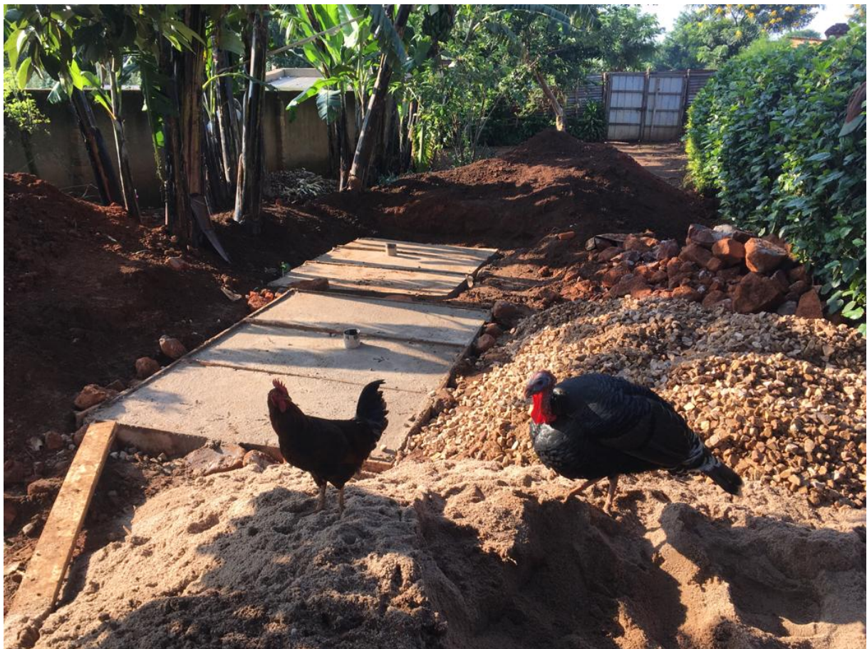
Puits perdus et avec la chape de béton terminée
